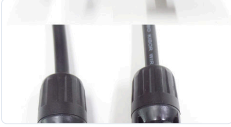
Fotoğraf 10.1 — MC4 konektör uyumu ve sıklığı (çapraz marka kontrolü) INV-07 MPPT-04 girişinde farklı marka MC4 eşleşmesi; termal görüntüde 41 °C fark.
